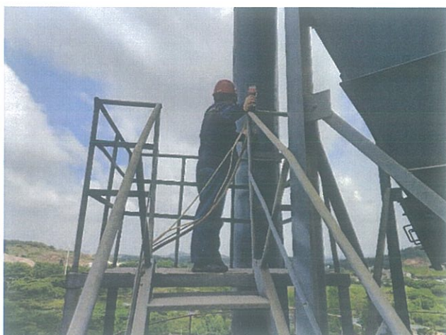
成品 8#库顶排放口（DA013）
