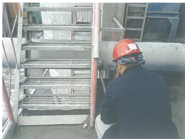
2#包装提升机排放口（DA018）
