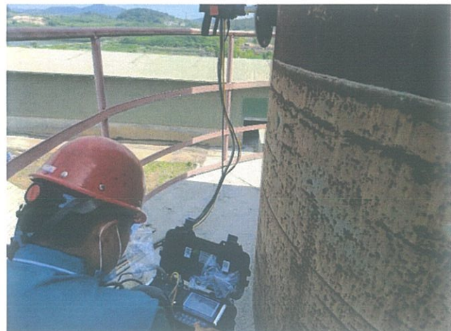
水泥窑窑头排放口（DA030）
