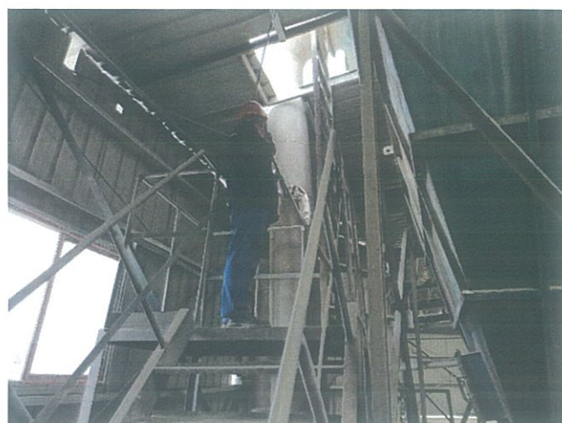
成品库南排放口（DA008）
