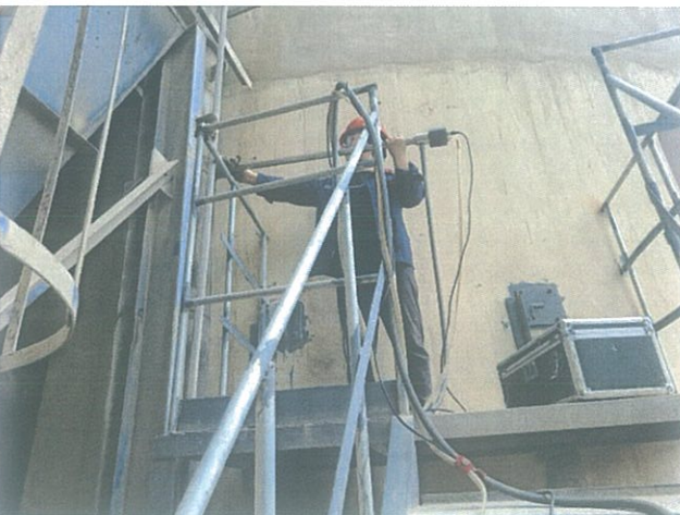
生料均化库底排放口（DA005）
