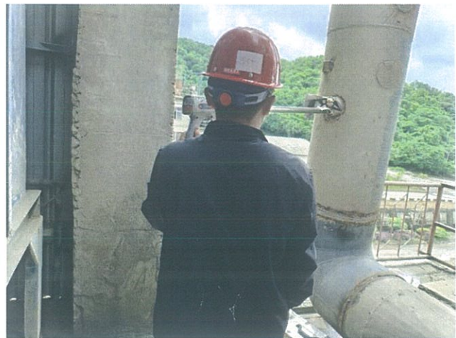
1#包装提升机排放口（DA028）
