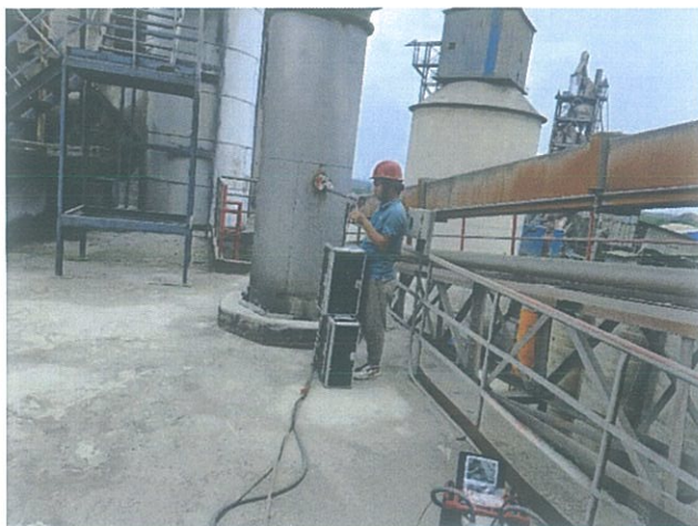
3#磨主收尘机排放口 (DA041)
