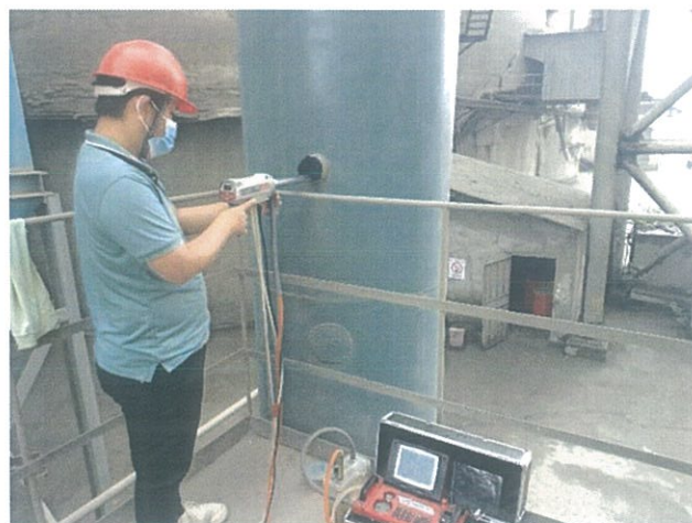
2#水泥磨机尾排放口（DA039）
