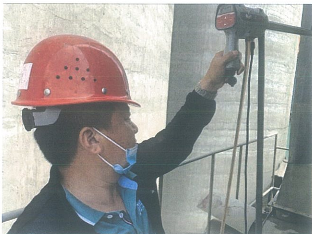
散泥 2#平台废气排放口（DA015）
