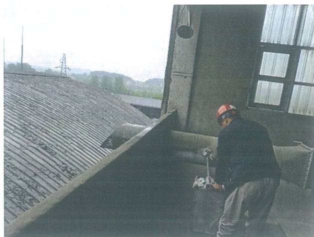
2#包装机废气排放口（DA046）
