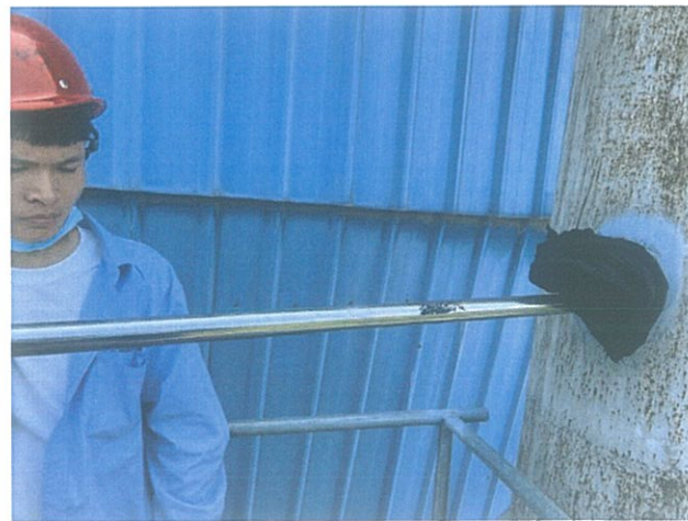
配粉 3#库顶废气排放口 (DA024)
